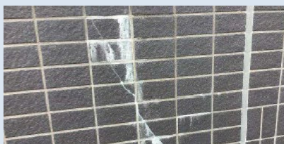
▲外壁タイル部ひび割れ・エフロレッセンス
